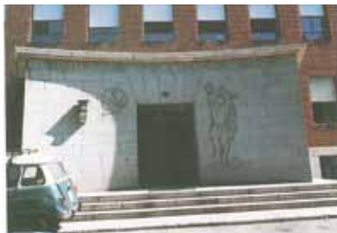
Fachada del Instituto de Óptica Daza de Valdés de Madrid en 1966.
